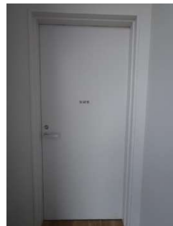
図11-5 階段室への扉
